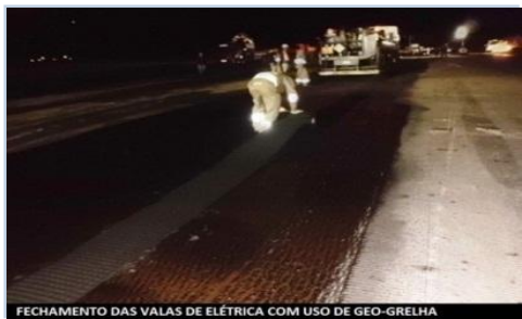
FECHAMENTO DAS VALAS DE ELÉTRICA COM USO DE GEO-GRELHA
