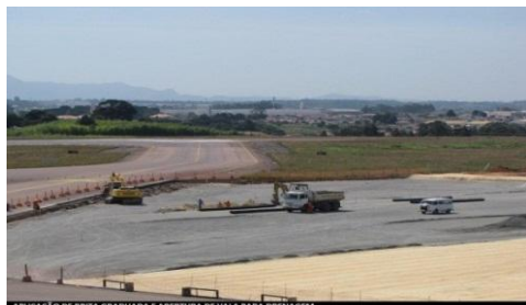
APLICAÇÃO DE BRITA GRADUADA E ABERTURA DE VALA PARA DRENAGEM
